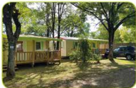
MOBIL-HOME TOUT CONFORT avec terrasse couverte
